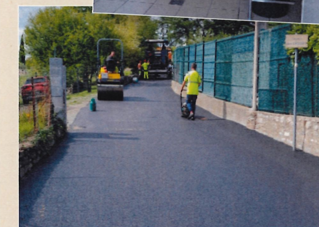
Réfection de voiries : Ce sont plus de 3 kilomètres de voies communales qui ont fait l'objet de travaux de goudronnage cet automne ; Chemin des Grosses, Chiffaux, Blachettes, Sauvayre, Carrefours : Missol, Montagnac, Gaude.
