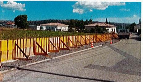
Les travaux de mise en sécurité des piétons, route des Champs, ont débuté par la réalisation d'un mur sur toute la longueur, avant la création d'un trottoir et la végétalisation des abords.
